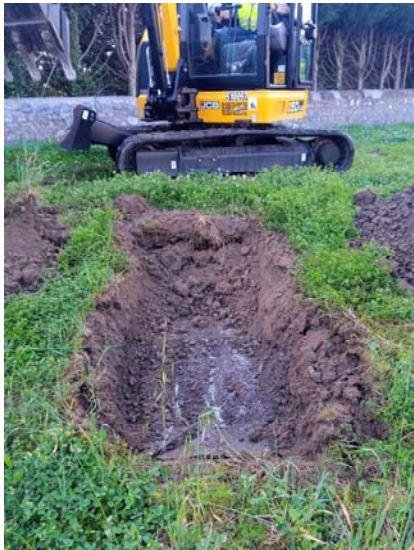
Cata 2 inicial con presencia de hormigón.
