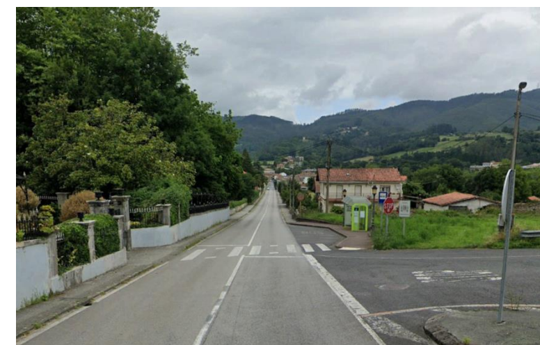
Parada de autobús y paso de peatones en la BI-3601
